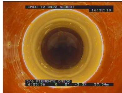
Al fine di procedere ad un ripristino delle tubazioni senza demolizioni, la *videoispezione* permette di verificare e valutare lo stato di dissesto in cui si trovano per definire la più idonea procedura di risanamento, un rivestimento no dig nella totalità della linea oppure un risanamento con packer, mirato al solo danno.
